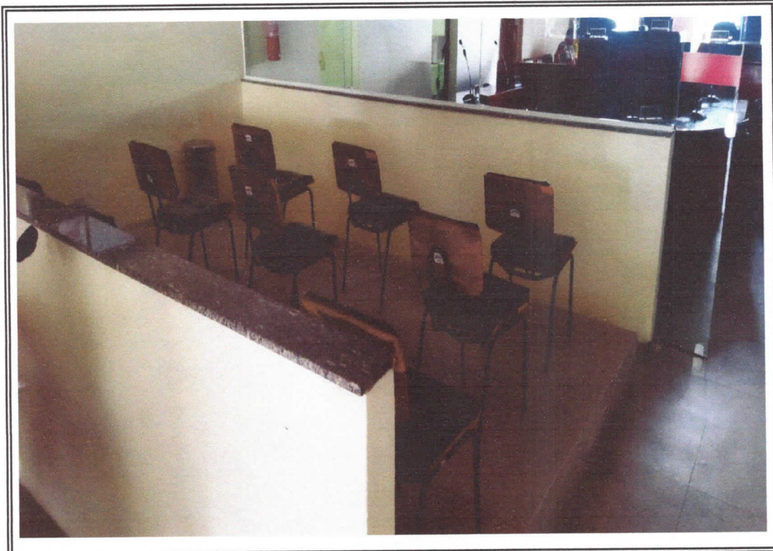
Foto 05 - Onde vai ser feito demolicao
